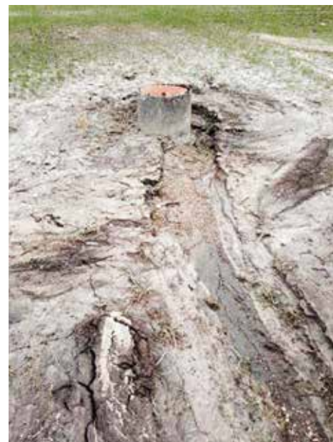
Erosion runt brunn. Här behövs anpassad skyddszon.
