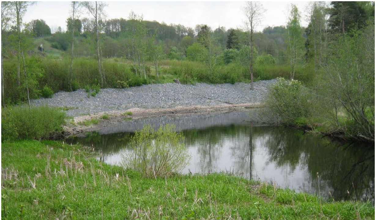
Figur 5. Erosionsskydd vid Viskan vid Näs i Kinna, Marks kommun. Foto: Bertil Fermstad, Marks kommun.
