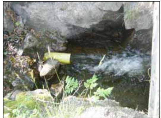
Figur 10. Sjöutlopp som utgör vandringshinder (tabell 3, hinder 3).
