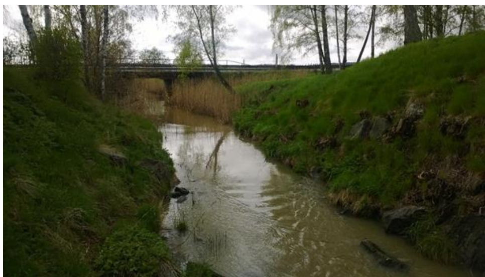
Figur 20. Exempel på bestämmande sektion vid övergång till en brantare sträcka. Bilden är tagen i riktning mot strömmen. Notera de karaktäristiska stående vågor som uppstår precis före den brantare delen i förgrunden. I bakgrunden råder subkritisk strömning (lugnflytande förhållanden).
