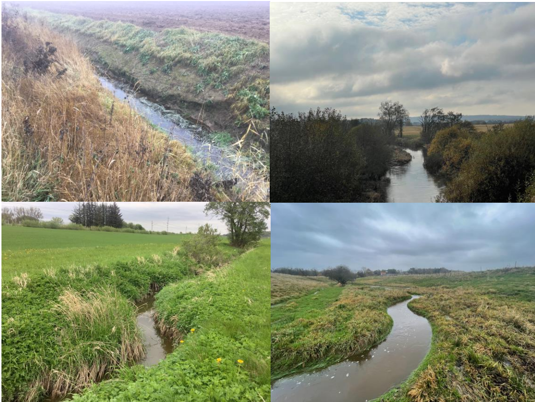
Figur 10. Fyra exempel på olika utvecklingsfaser i ett vattendrag. Överst till vänster en nyrensad/nygrävd fåra där kraftig erosion förekommer, dvs fåran är långt mycket instabil och mycket sediment omfördelas och transporteras nedströms. Fåran är i utveckling 3 (se figur 9) Överst till höger är ett större vattendrag som inte har rensats på lång tid. Här har nya svämplan (sekundära svämplan (bildats på en lägre nivå än de naturliga) och fåran smalnar av. Vattendraget är i utveckling 4 (se figur 9) och är förhållandevis stabilt. Nere till vänster är ett mindre vattendrag med som har nått liknande utveckling som ovan till höger. Nere till vänster är ett återställt vattendrag där vattennivån ligger mycket nära svämplanen. Vattendraget är i utveckling 1 och är i jämvikt.
