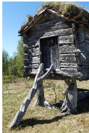
Gåsfotsboden (juelkiebuerie) med rotben och torvtak vid Silisens sameviste. Foto: Lena Lundevaller.
