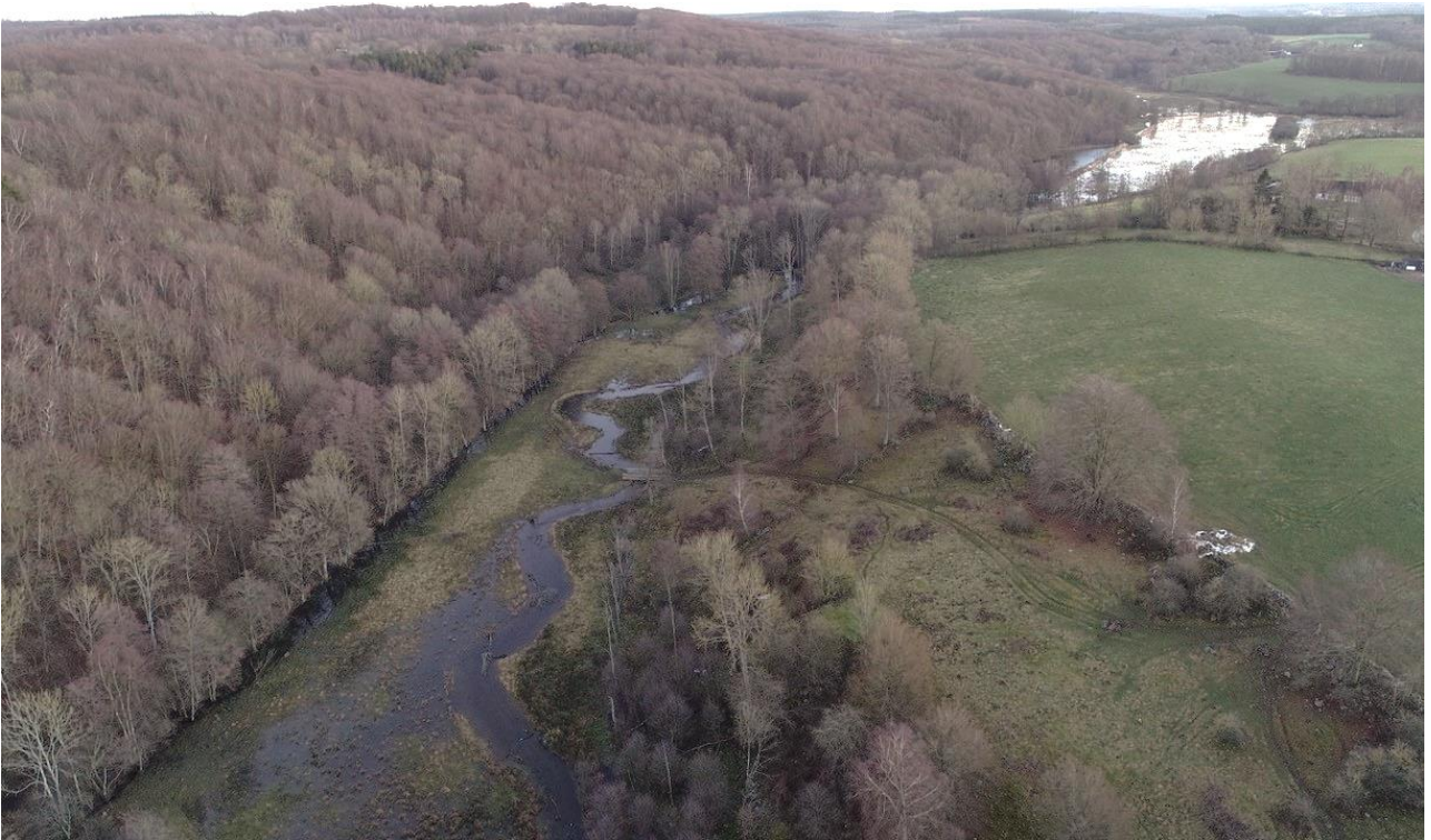
Bild: Exempel på återmeandrad sträcka vid Bauseröd i Hallabäcken, Vege å. En meandrande fåra har återställts och det tidigare rätad diket (längsmed trädridån till väster) har lagts igen.
