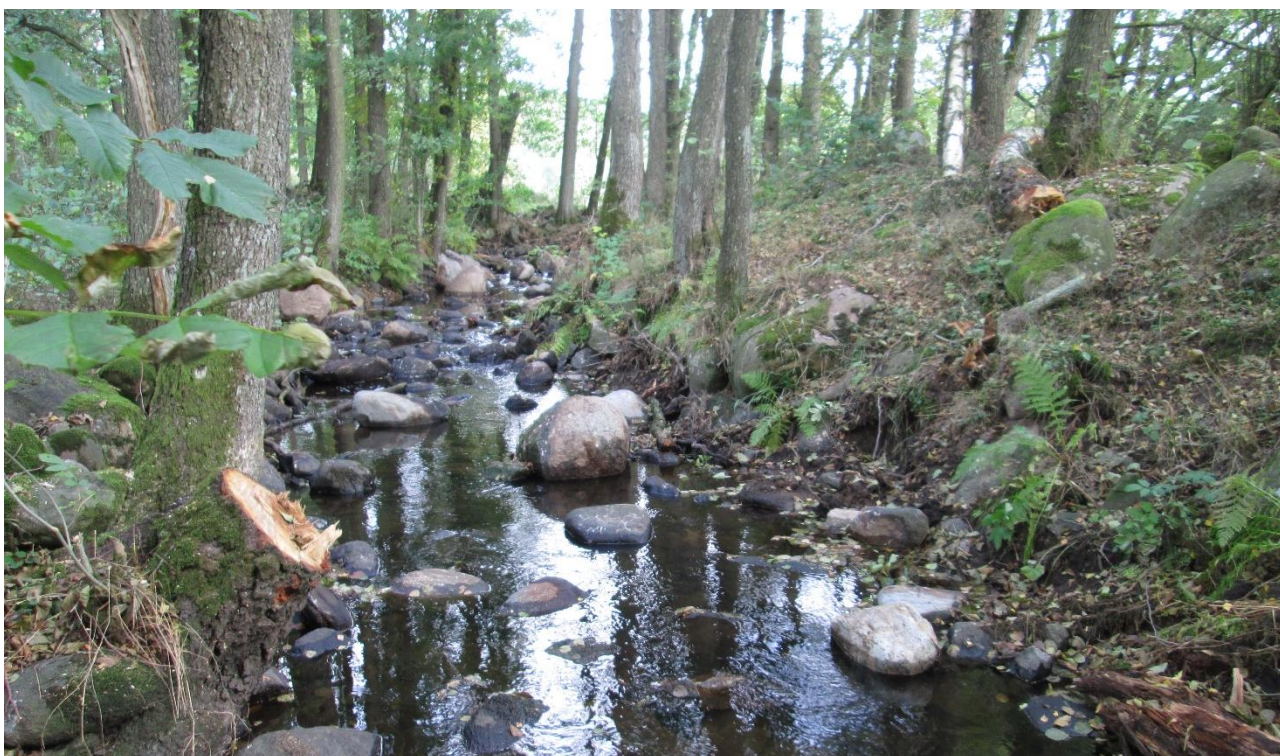
Bild: Exempel på blockrestaurerad strömsträcka vid Åvarp i Vege å. Block och sten har tagits från rensvallar längsmed strandkanten och lagts tillbaka i fåran.
