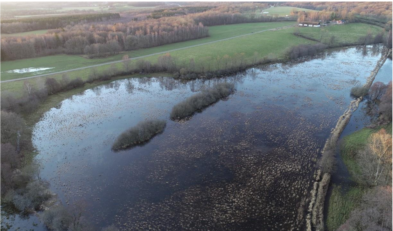
Bild: Exempel på återställt svämplan vid Bauseröd i Hallabäcken, Vege å. En meandrande fåra har återställts och det tidigare rätad diket (till höger) har lagts igen. Fotot är taget vid högvatten då vattnet bräddar ut på svämplanet.
