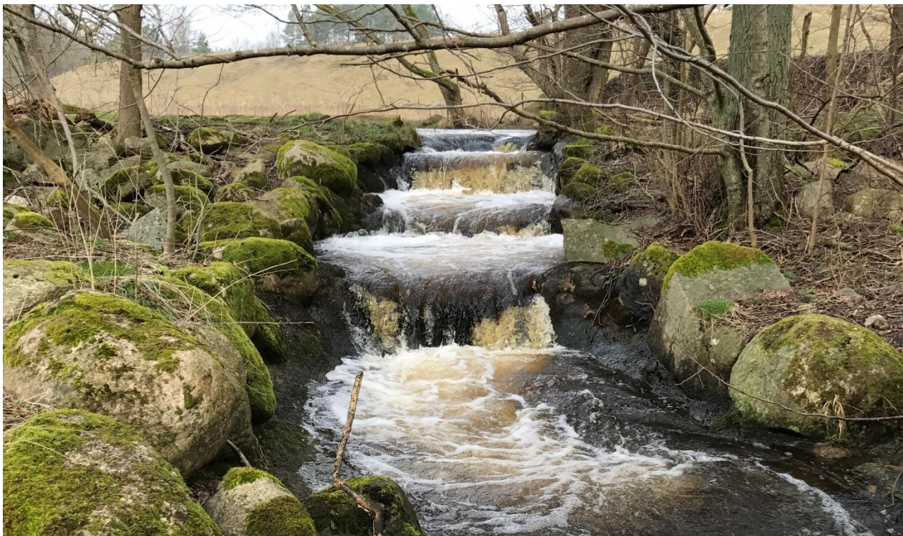
Bild: Exempel på partiellt vandringshinder i Verkeån, i form av kammartrappa. Här finns möjlighet att återskapa fria vandringsvägar.
