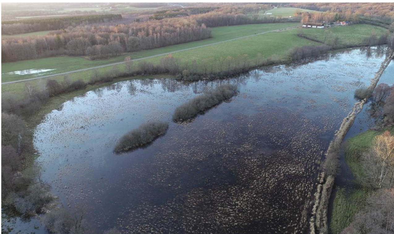
Bild: Exempel på återställt svämplan vid Bauseröd i Hallabäcken, Vege å. En meandrande fåra har återställts och det tidigare rätad diket (till höger) har lagts igen. Fotot är taget vid högvatten när vattnet bräddar ut på svämplanet.
