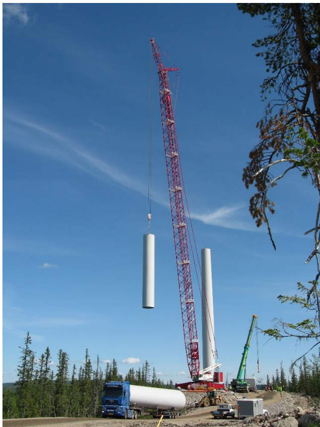
Figur 8 Montering av vindkraftverk
