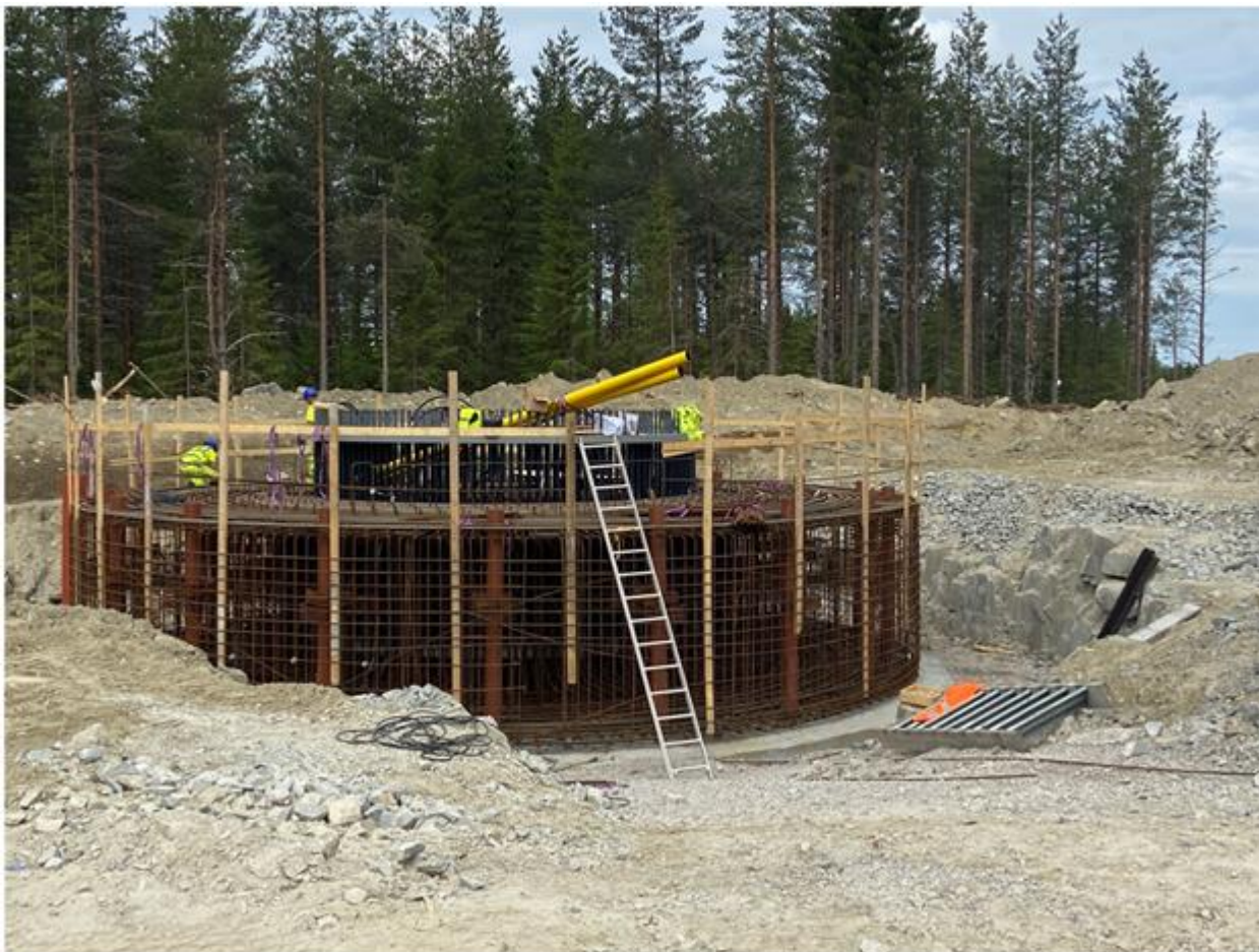
Figur 4 Bergförankrat fundament
