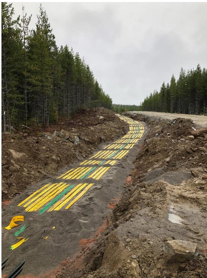
Figur 10 Kabelgrävning längs med befintlig väg
