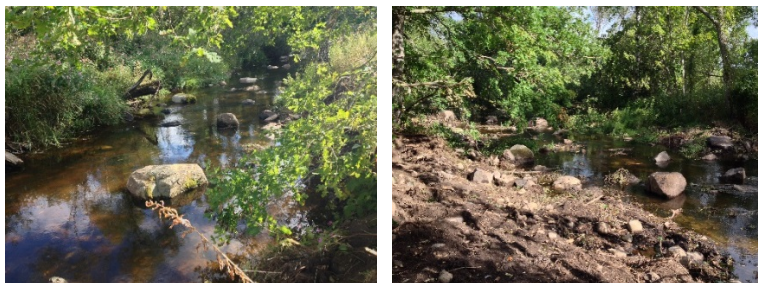
Bild 16. Blockrestaurering (vänster) och borttagande av granskog för plantering av löv (höger).
