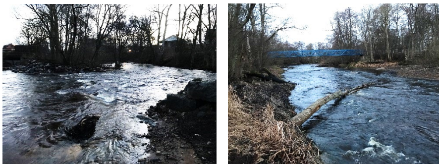
Bild 14. Området vid dämmet (vänster) och dämningområdet (höger) ett halvår efter att åtgärden var genomförd.
