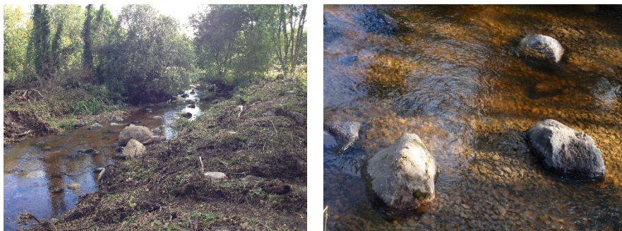
Bild 17. Röjd mark för kantavplaning (vänster) och utlagt lekgrus (höger).
