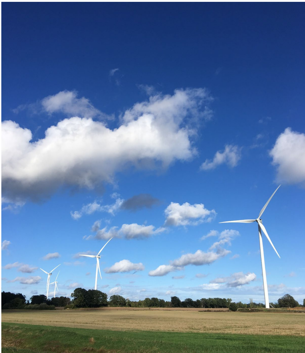
Vindkraftverk i Kalmar län.
