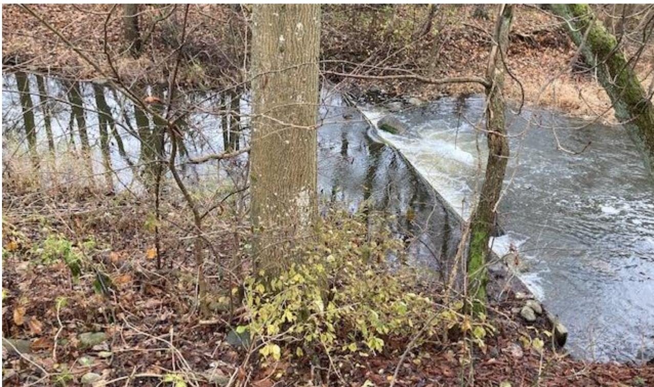
Bild: Exempel på ett partiellt vandringshinder i Bråån vid Eslövs golfklubb. Här finns möjlighet att återskapa fria vandringsvägar.
