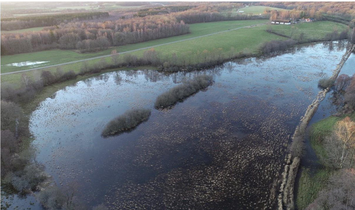
Bild: Exempel på återställt svämplan vid Bauseröd i Hallabäcken, Vege å. En meandrande fåra har återställts och det tidigare rätad diket (till höger) har lagts igen. Fotot taget vid högvatten då vattnet bräddar ut på svämplanet.
