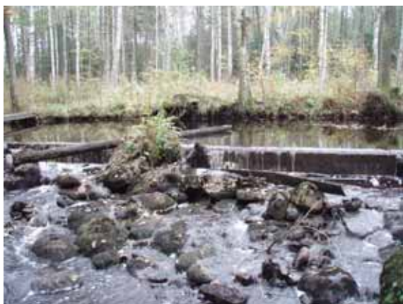
Figur 23. Vandringshinder nr 3. Fördämning som inte längre fyller någon funktion. Fotograf: Jonas Johansson, Calluna AB.
