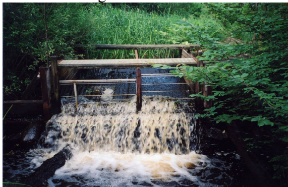
Ålkista (vh7) på sträcka 88 (A-prot.) i Klingstorpabäcken-Guvarp. Ett definitivt vandringshinder. Foto: Samuel Hylander.
