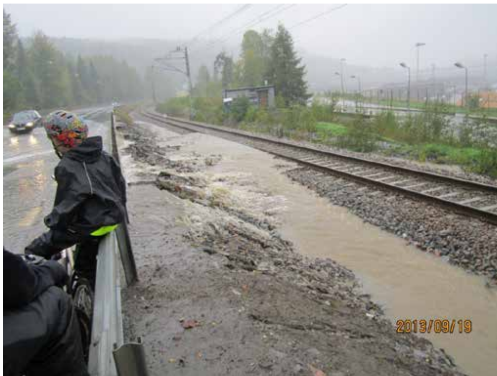
Figur 28: Översvämning av riksväg 90 och järnväg vid Väja den 19 september 2013. Foto: Kramfors kommun.
